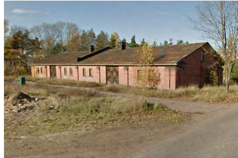
Kuva: Rakennus ennen peruskorjausta. / Google Street View 2009.
