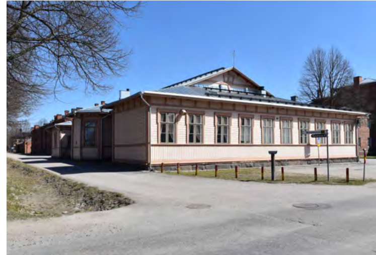
Kuva: Rakennuksen länsisiivestä on poistettu kaksi sisäänkäyntiä ja ikkunat yhtenäistetty kooltaan, mutta muulta osin tyyli on entisenlainen. Rakennuksen erikoisuutena on lohkokivijalan yläosassa näkyvä punatiilikkeros.
