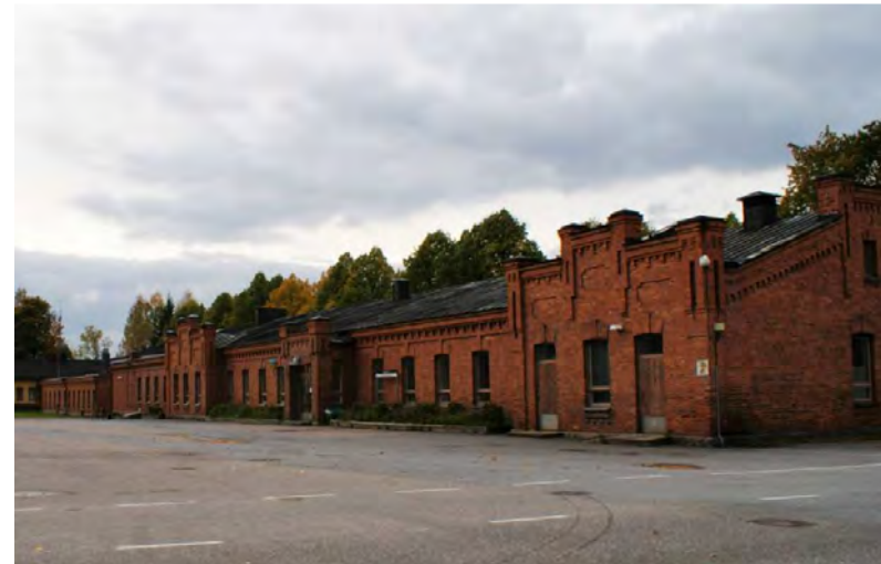
Kuva: Pitkillä sivuilla on kaksi seinälinjasta ulkonevaa risaliittia, jotka osoittavat keittiöiden paikat. Syvärunkoisen rakennuksen päädyissä ja pääsisäänkäynnin portaalissa on gootilaishenkiset sakaramuurit (ainoat peililaiheilla koristemuurauksella varustetut) ja räystäään alla kulkee hammaslista.
