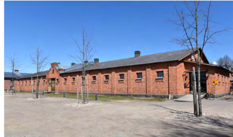
Kuva: Venäläiskauden tallirakennusten julkisivuja leimaa struktuuri, joka syntyy kapeista liseeneistä ja pienistä vaakaikkunoista, joiden alaosassa on koristeellinen muuraus.
