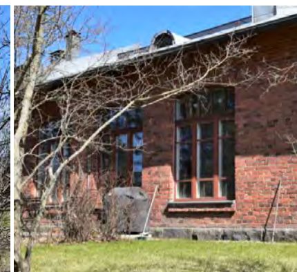
Kuva: Uudet, isot ikkunat.
