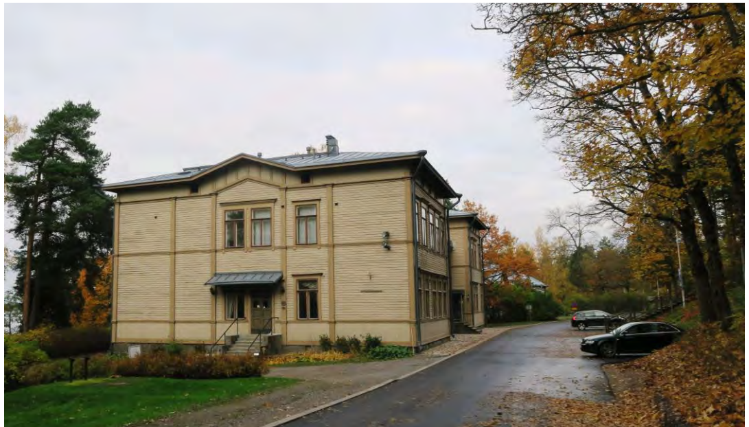
Kuva 7. Baltian jääjärven B III muinaisranta, jonka terassille Upseerikerho on rakennettu.
