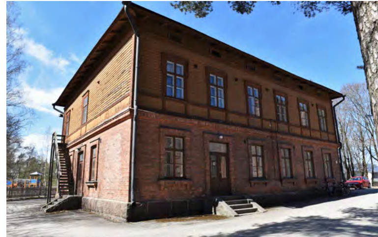
Kuva: Asuinrakennuksessa on kuusiruutuiset ristikarmi-ikkunat, lasiaukolliset puuovet ja kiviportaati. Päädyistä on muurattu umpeen yksi ikkuna.
