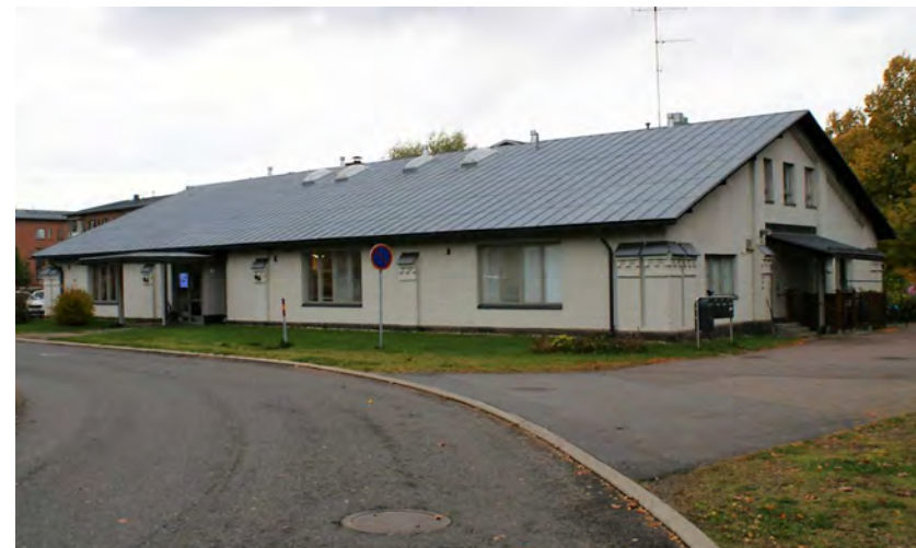
Kuva: Yhdessä rakennuksen suurista oviaukoista on pääsisäänkäynti, kolme muuta on pienennetty ikkunoiksi. Päätyovet on tehty ikkunaparin paikalle. Leveät ikkunat, kattovalokuvut sekä sisäänkäynnin katos ja tuulikaappi ovat 1960-luvun suunnittelua.
