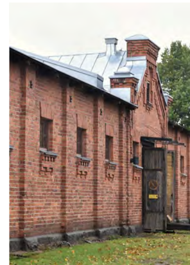
Kuva Ristipäädyn harjalla on sakara, räystäään alla puiset profiloidut katonkannattajat.
