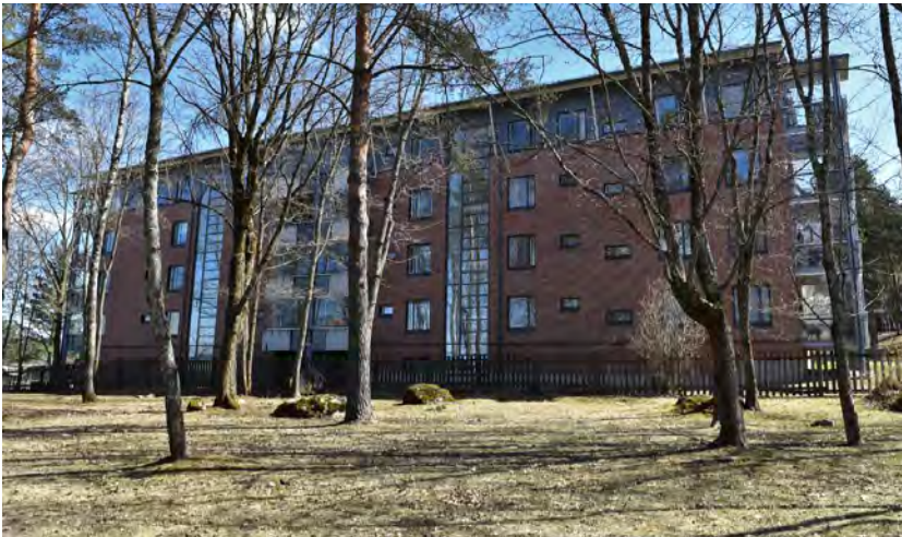
Kuva: Hautausmaan reunalla on IV-kerroksinen betonielementtirunkoinen lamellitalo vuodelta 2002.
