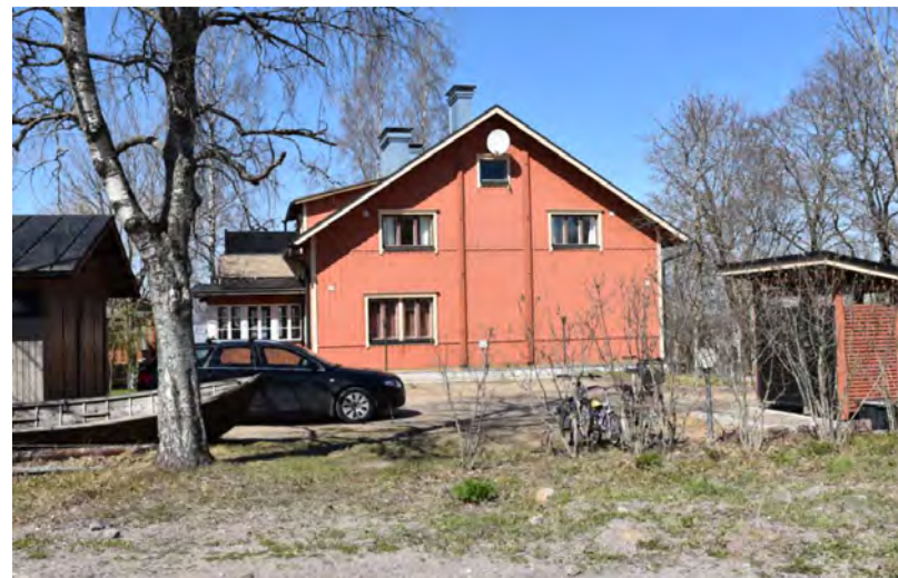
Kuva: Makasiini sai uuden käyttötarkoituksen myötä jälleenrakennuskauden asuinrakennukselle tyypillisen ulkoasun, johon on myöhemmin tehty pieniä muutoksia, kuten lasikuisti, parveke ja pulpettikattoinen poikkipääty.
