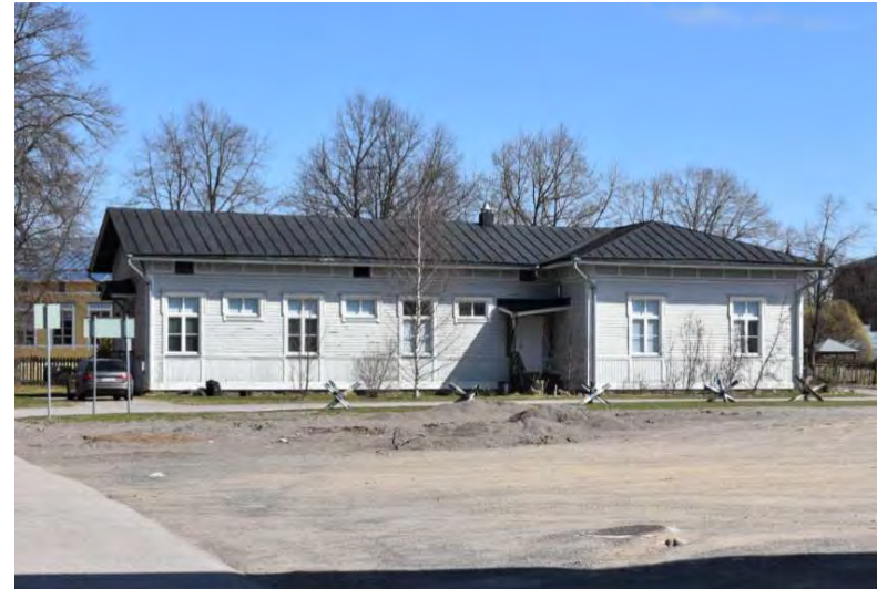
Kuva: Päävartion julkisivu länteen. Vyöhykkeittäin suuntaa vaihtava lautavuoraus ja yläosan peilikomeronauha ovat tyypillisiä kasarmialueen puurakennuksille. Päävartiorakennuksessa julkisivun koristelu on rikkainta talon eteläisivulla, pääsisäänkäynnin kohdalla. Katto on varustettu räystäskouruin ja syöksytorvin.
