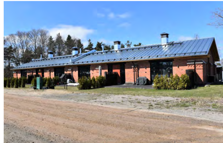
Kuva: Rakennus vuonna 2011.
