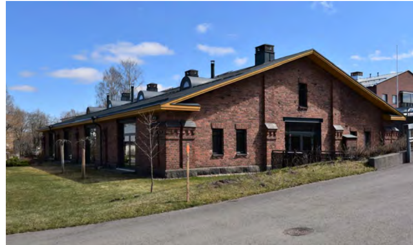
Kuva: Kahdessa varastorakennuksessa on syvä runko ja loiva katto, jonka kulmissa räystääs kääntyy kissanpenkiksi. Rakennuksen peltikate on uusittu, mutta puolipyöreät ullakkoikkunat on säilytetty. Asuntokäyttö on tuonut paljon lasipintaa tiilen rinnalle.
