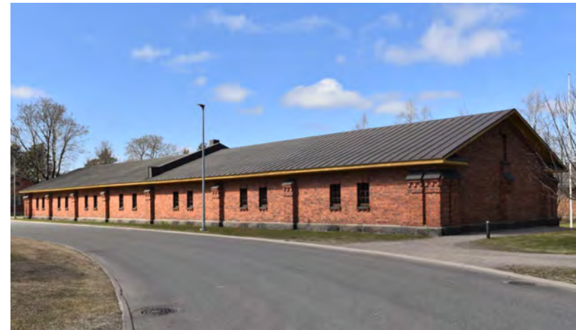
Kuva: Venäläiskauden varastorakennusten pitkiä julkisivuja rytmittävät ikkunaparit ja liseenit. Ikkunat ovat kapeita ja kuusiruutuisia. Niissä on kalterit.
