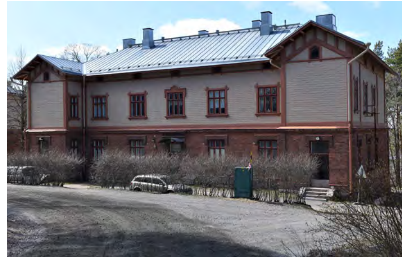
Kuva: Kaksikerroksen talon ulkoasua luonnehtii vaakalinjaisuus, joka syntyy kerroksittain vaihtuvasta julkisivumateriaalista – lohkokivi, tiili ja lauta – ja vyöhykkeisyyttä korostavista leveistä kerroslistoista. Yläkerroksen koristeaiheet ikkunakehyksissä ja päätykolmioissa ovat samanlaisia kuin alueen kahdessa aliupseeritalossa.
