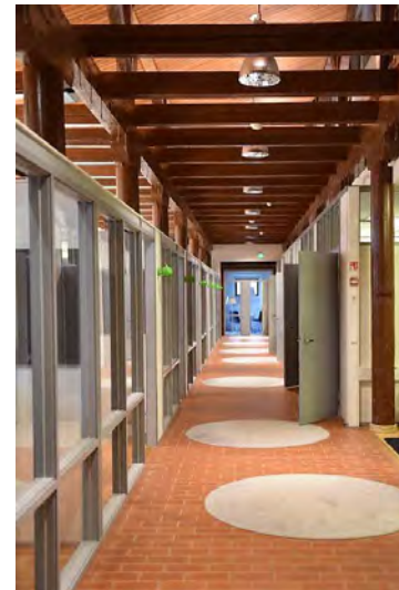
Kuva: Sisätilat on uudistettu, mutta puupilareita ja yläpohjan puurakenteita on hyödynnetty sisutuksessa.
