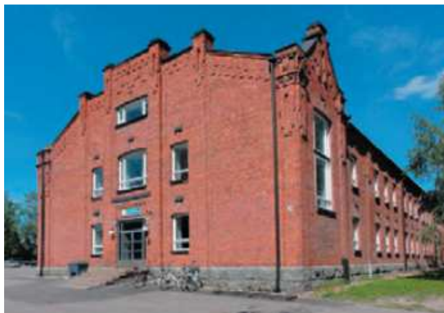
Kuva: Tiilikasarmi vuodelta 1913, Hämeenlinnan kasarmi, Hämeenlinna. / Kuva (osa), RHS, Lauri Putkonen 2012. Ramboll.
