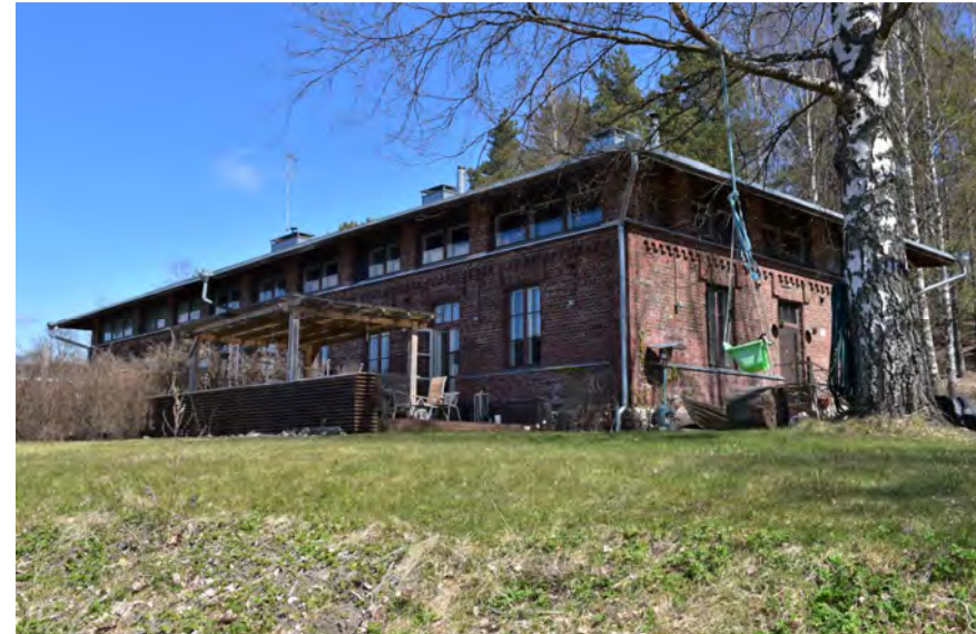
Kuva: Asuntokäytössä olevaan entiseen saunarakennukseen on lisätty ikkunoita sekä räystäään alapuolelle että puhkaisemalla ikkunoiksi entiset saunan valeikkunat.
