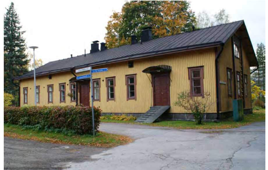
Kuva: Alkuperäisten rakennuspiirustusten mukaan varusvarasto oli alueen muiden ulkorakennusten tavoin vaakalaudoitettu. Rakennuksessa on vanhat ikkunat; yläruutu on saranoitu yläreunastaan. Ulko-ovet on vaihdettu uusiin; samaa ovityyppiä on käytetty muissakin alueen rakennuksissa.
