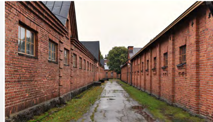
1920-luvun tallirakennus nro 19.
